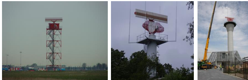
Figuur 14: De TAR 1 (links) geplaatst tussen de taxibanen op het vliegveld, de TAR 4 (midden) geplaatst in het Amsterdamse Bos. Deze laatste radar is in 2017 vervangen door een nieuwe TAR West (rechts) gelegen naast de taxibaan richting de Polderbaan (Bron: LVNL).
