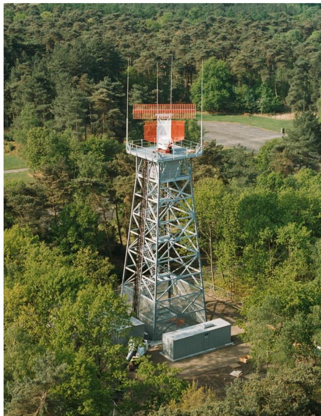
Figuur 4: De Military Approach and Surveillance System (MASS) verkeersleidingsradar. De onderste antenne is van de primaire radar. Daarboven bevindt zich de antenne van de secundaire radar. Het geheel draait rond met 15 omwentelingen per minuut (Bron: Ministerie van Defensie).
