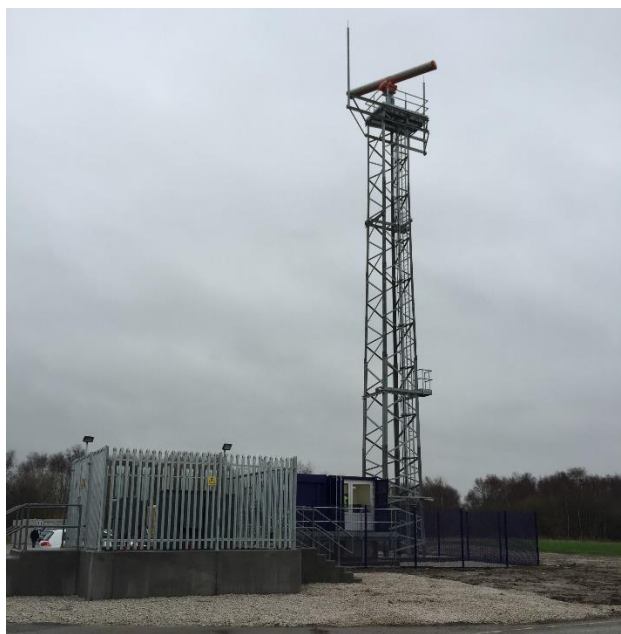
Figuur 28 Een typische opstelling van de Scanter 4002 infill radar van Terma zoals hier opgesteld in het Verenigd Koninkrijk (Foto Terma).
