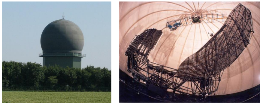
Figuur 32: De MPR gevechtsleidingsradar bij Wier. Rechts de radarantenne in de radome (Bron: Ministerie van Defensie).
