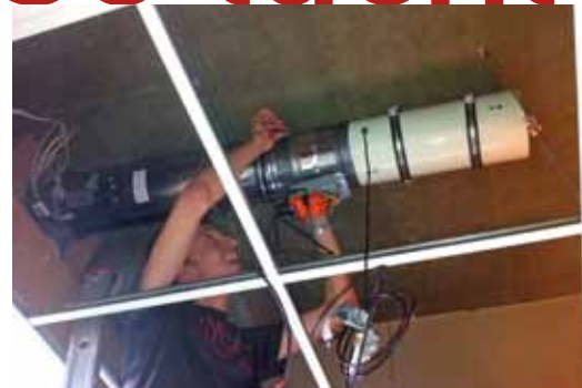
Het plaatsen van de decentrale ventilator, luchtklep en lagedrukfilter.
